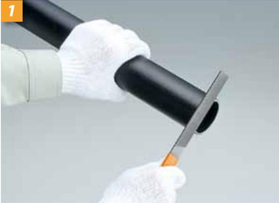
管端部のバリを取り除き、表面を清掃します。
