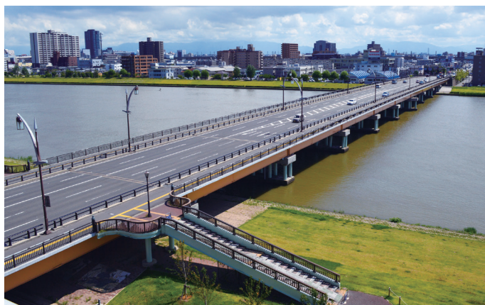
◎ひび割れ注入後50年経過した昭和大橋 【2014年9月2日撮影】
