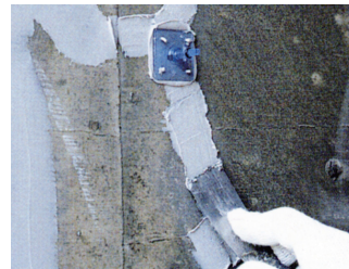
▲取付けパイプの接着とシーリング
