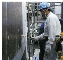
プライマー塗布
