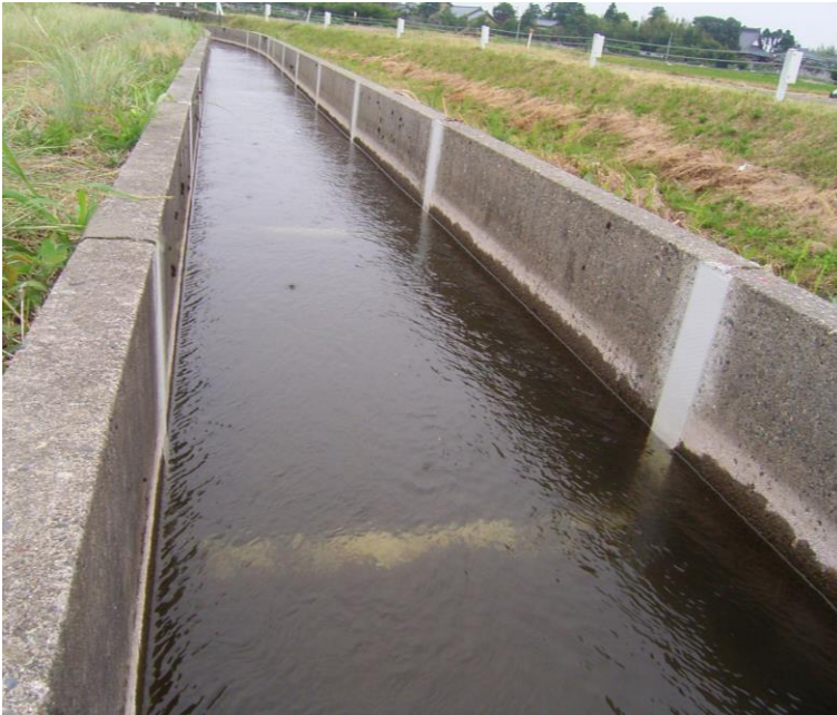
水路の目地補修
