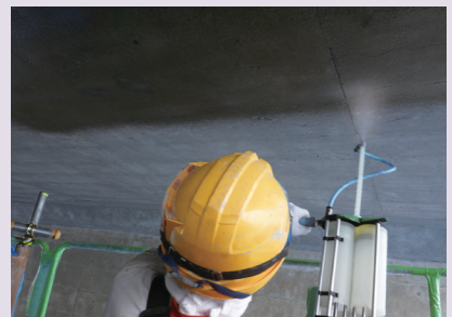
▲ネオプライマーEX(速乾型)施工状況
