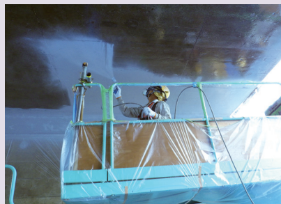
▲ネオライナーEX 施工状況
