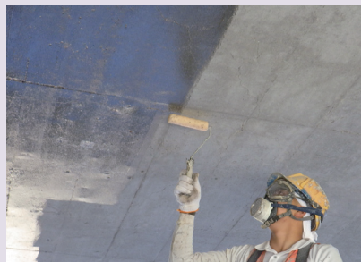
▲ネオプライマーEX 施工状況
