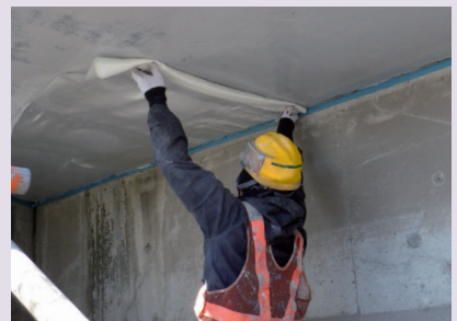
▲ネオライナーEXシート貼付け状況
