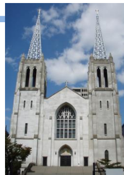
2014年10月撮影(施工後29年経過)
