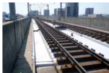
◀鉄道橋上部工の防水対策
