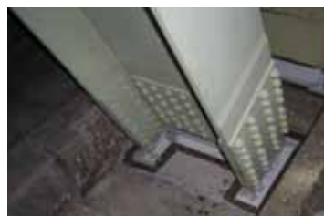
◀トラス斜材格点部の水掛かり防止対策
