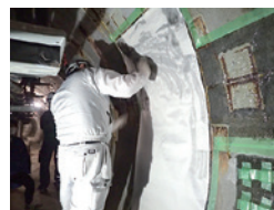
④ シート貼付け・ 接着剤含浸
