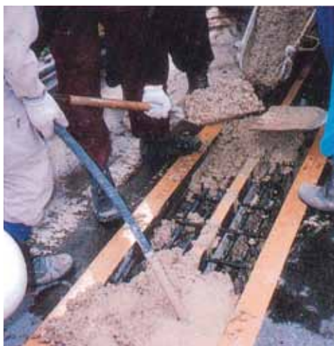
⑤コンクリート打設
