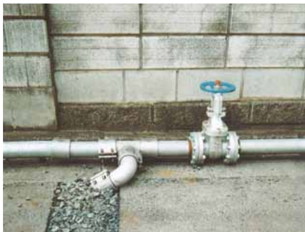
▲ 上水道仮設配管/鋼管(白ガス管)
