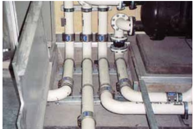
▲ビル設備/冷却水配管 ナイロンコーティング鋼管
