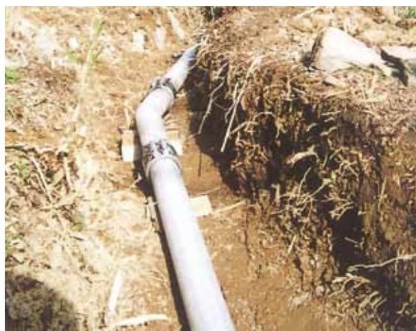
▲ 水道施設/埋設送水管 ステンレス鋼管 〈この写真は埋設時の防食処理を行う前の状況です〉
