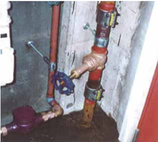
▲集合住宅/バルブの交換 ライニング鋼管(VB)
