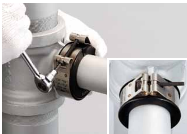
⑤ ラチェット等でケーシングが密着するまでボルトを締め付けます。
