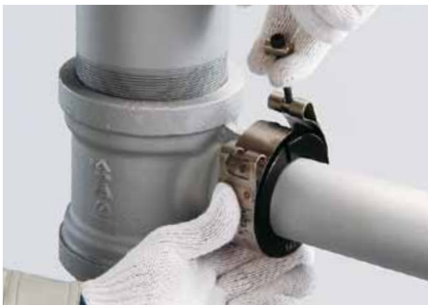
③ ゴムの上にケーシングをかぶせます。
